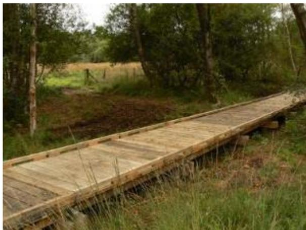
Figure 25 : Exemple de platelage bois (source : <https://www.marcanterra.fr/>)
