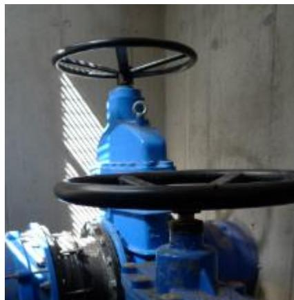
Figure 68 : Exemple de volant de manœuvre des vannes
