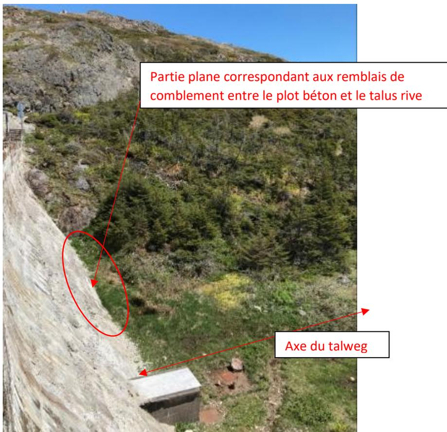
Figure 16 : Photo du parement aval de l'ancien barrage
