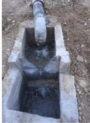
Figure 74 : Exemple de seuil de mesure de débit
