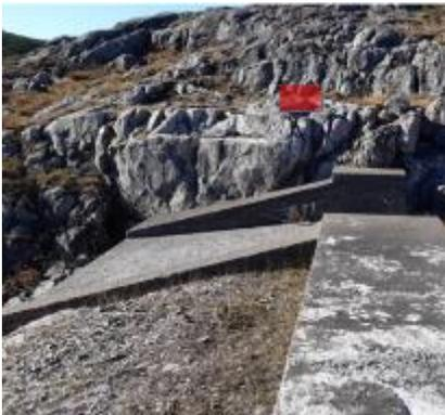
Figure 46 : Implantation de l'appui rive droite de la passerelle
