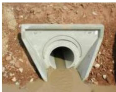
Figure 34: Exemple exutoire drain du barrage - Tête de pont béton
